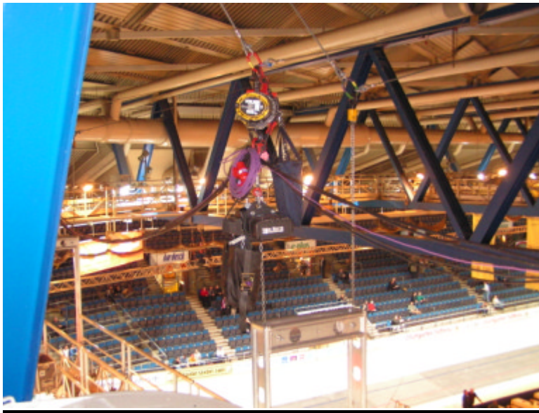
2 Aufhängepunkte (1 x Hebezeug D8 „geblockt“ mit C1 Vario-Lift darunter) C1 Kettenhaken am zweiten Aufhängepunkt!
